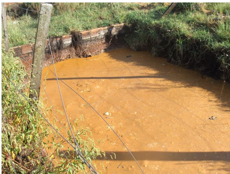
Imagem 183: Município de Tupanciretã – Área de decantação dos efluentes da Indústria de Laticínios
