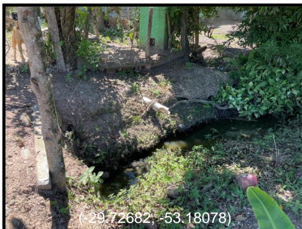
(-29.72682, -53.18078) Vala Pluvial e esgoto com ligação direta Rua Edmundo Rohde
